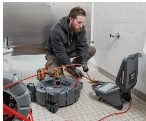
▲管内カメラで配管内を確認しながら
