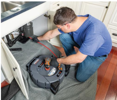
▲管内カメラで配管内を確認しながら
